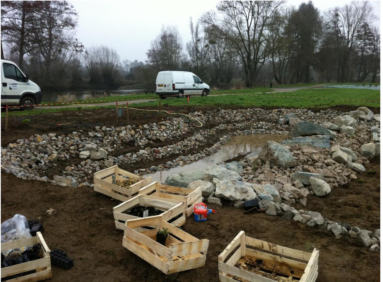
Enrochement après avoir complété de substrat et mise en eau par pompage dans la rivière ; végétalisation de la zone humide et des paliers de la mare, avant complet remplissage.
