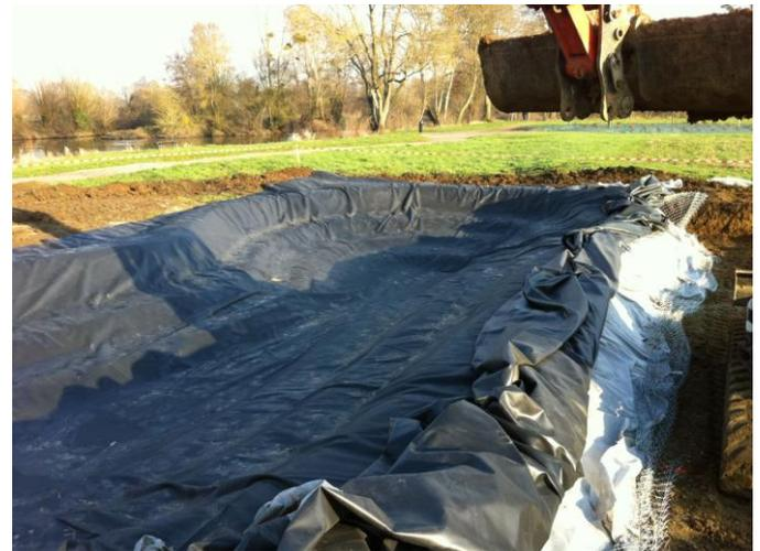
Mise en place du géotextile puis de la bâche de 120 m<sup>2</sup>, côté mare
